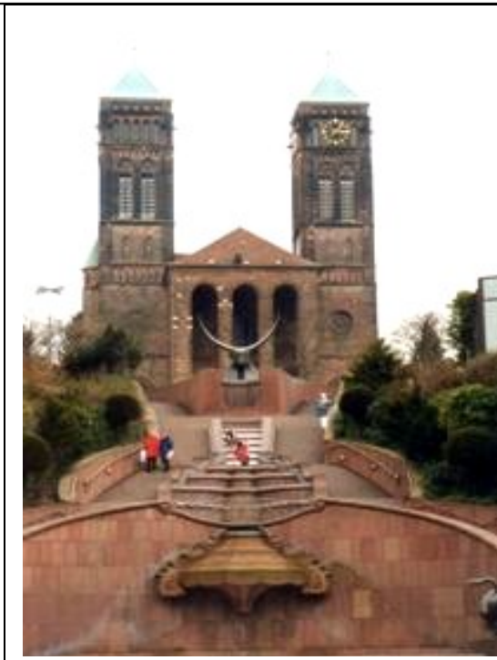
Treppenanlagen in Pirmasens, Stadt der sieben Hügel
